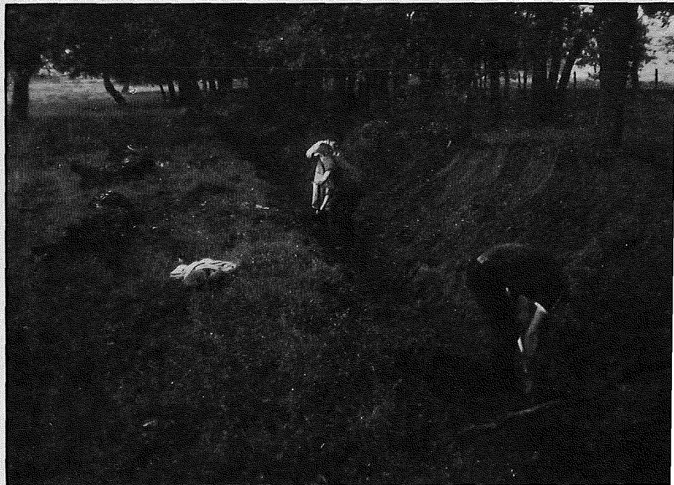
Restauratie van het wallichaam van een houtwal
